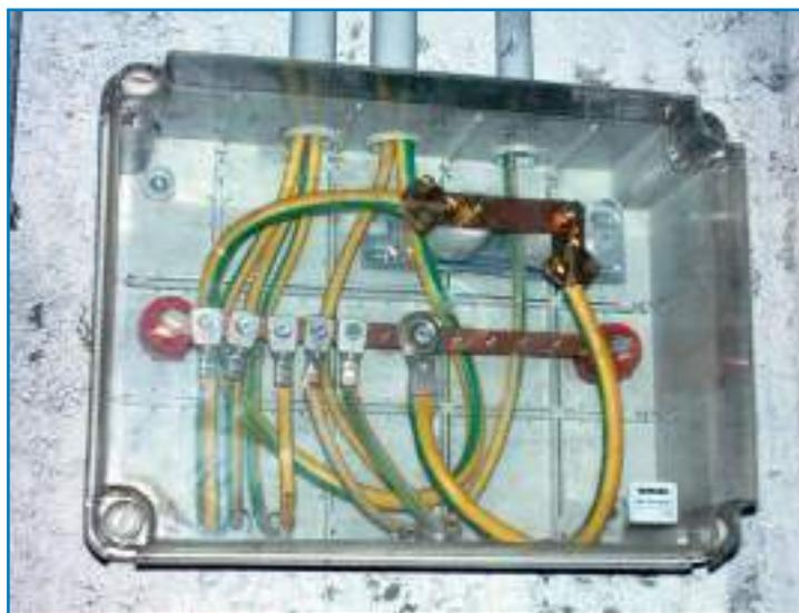
**Nodo equipotenziale principale. Il cavo di maggior sezione (16 mm<sup>2</sup>) è il conduttore di terra collegato ai dispersori.**
