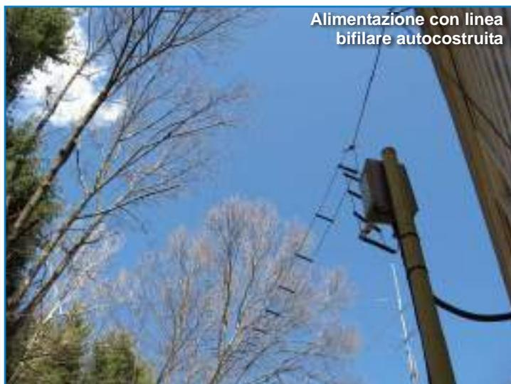
Alimentazione con linea bifilare autocostruita
